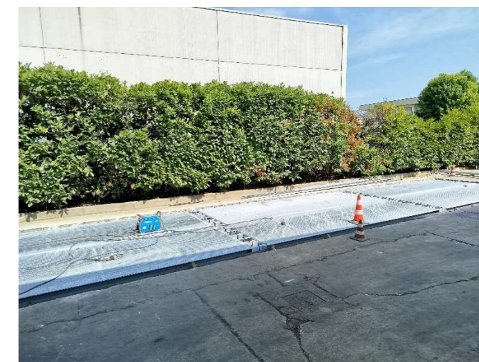
Lavori di sostituzione pesa
