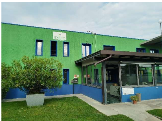
Ingresso agli uffici
